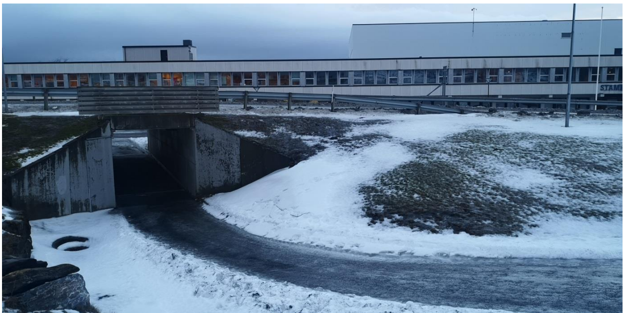
Figure 12: Målet er å få flere til å benytte eksisterende undergang på bildet.
